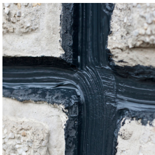
3. Po vytvrdnutí je membrána elastická a veľmi pevná
